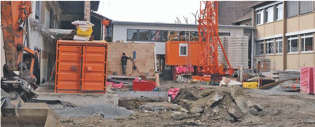
Die Bauarbeiten sind in vollem Gange, doch die Kosten bereiten Kopfzerbrechen. sub-Bild: mu
