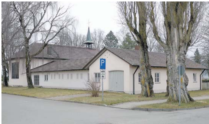
Das Friedhofsgebäude aus dem Jahr 1955 soll umfassend renoviert werden. swb-Bild: Siegenführ Gassner Architekten
