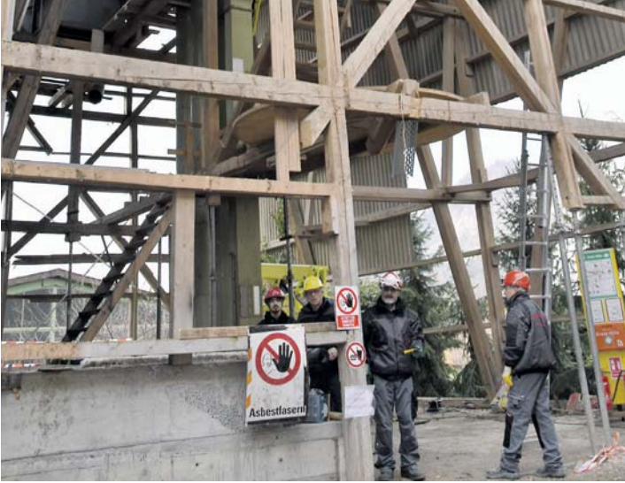
Die Stunden sind gezählt für die alte Mühle in Neuhausen. Seit mehreren Jahren steht das Gebäude bereits leer, nun sind die Abrissarbeiten bereits in vollem Gange. Der Abriss ist kein leichtes Unterfangen, denn die Außenverkleidung des Gebäudes besteht aus asbesthaltigen Platten, die von der Spezialfirma »Entkernung Bodensee« abgebaut werden müssen. Erschwert werden die Arbeiten zusätzlich durch das verwinkelte, unebene Grundstück. Die Fachleute werden noch einige Tage zu tun haben, bis die Außenverkleidung und das marode Holzträgerwerk verschwunden sind. Danach sollen auf dem Grundstück Wohnhäuser entstehen. swb-Bild: dhet
