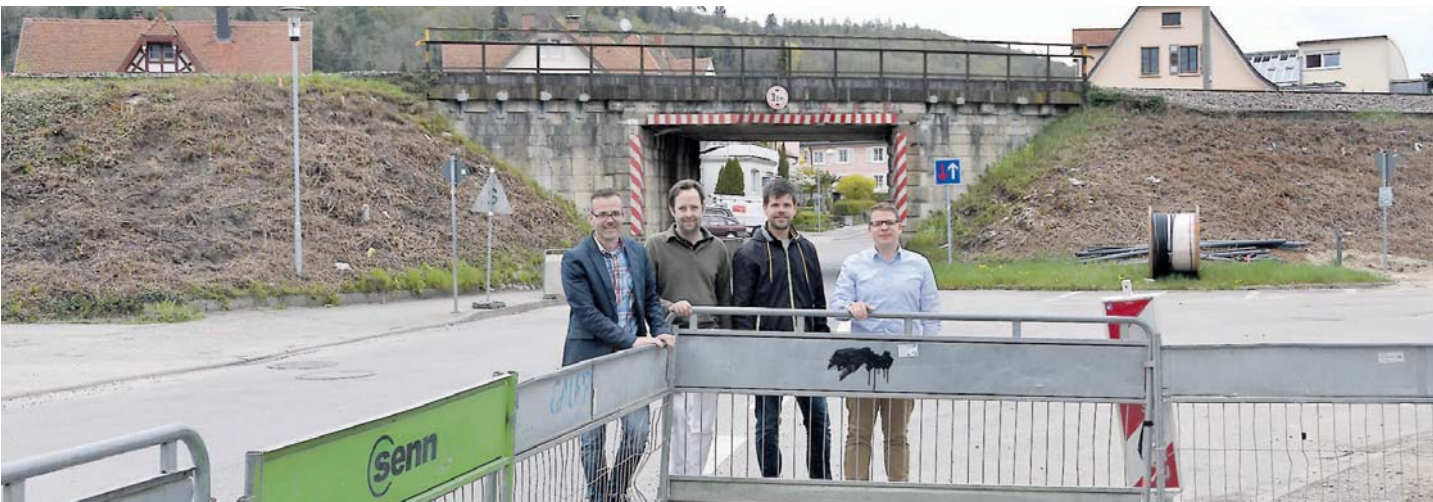
Markus Jautz, Projektleiter bei DB Netze, Bürgermeister Dr. Michael Klinger, Patrick Pingitzer vom Bauamt und Stefan Kleinbub von DB Netze vor der alten Eisenbahnbrücke, die bald Geschichte sein wird.
