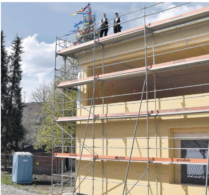
Jüngst konnte Richtfest gefeiert werden beim Anbau der Engener Grundschule.
