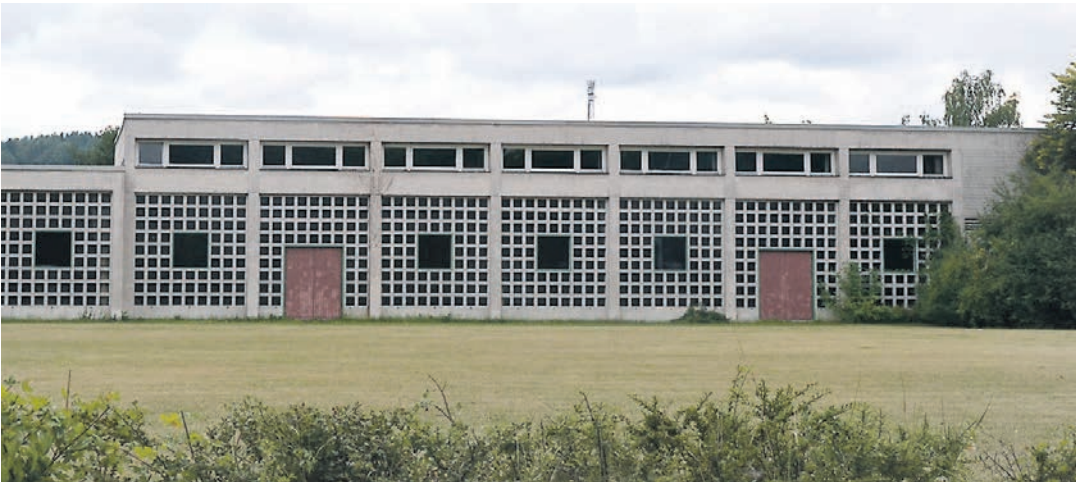
Die alte Stadthalle ist in die Jahre gekommen und soll einer neuen Sporthalle weichen. swb-Bild: Archiv
