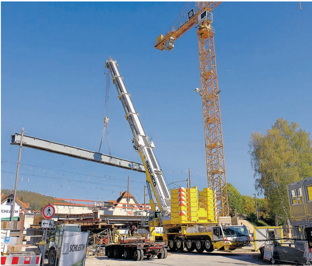
Eine spektakuläre Aktion war das Ausheben der provisorischen Brücken an der Hilzinger Straße.
