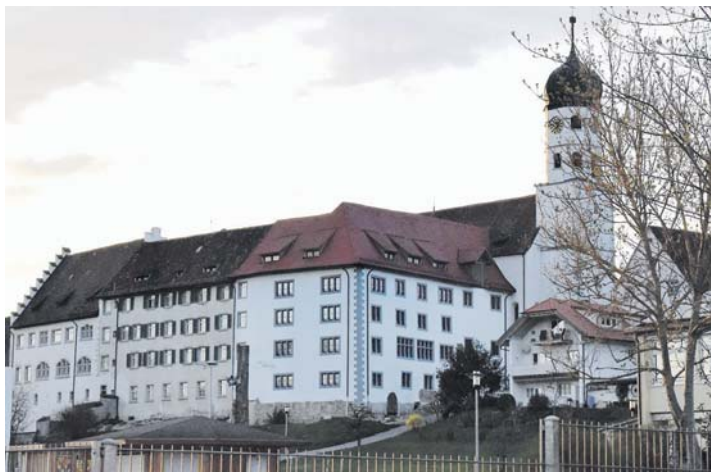
Die künftige Nutzung des Probsteigebäudes vom Chorherrenstift ist geklärt. Im Erdgeschoss und im ersten Obergeschoss entsteht ein Gastronomiebetrieb mit Gästezimmern im zweiten und dritten Obergeschoss. Das Dachgeschoss wird zu einem Veranstaltungssaal ausgebaut. swb-Bild: hz
