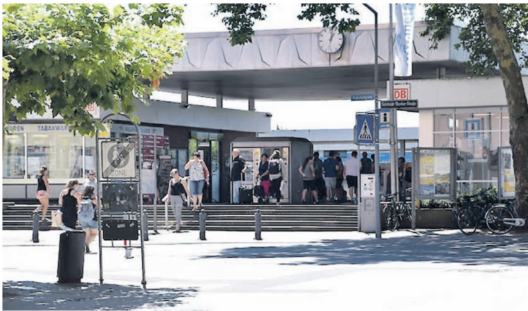
Durch die alte Unterführung geht es derzeit noch an den See. Noch, denn der Rat hat sich in seiner jüngsten Sitzung für den Bau der modifizierten Vorzugsvariante »light« ausgesprochen. swb-Bild: gü
