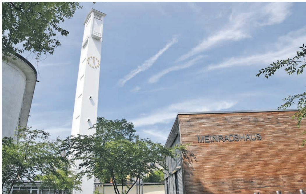
In neuem Glanz: Die St. Meinradskirche in Radolfzell wurde für Kosten in Höhe von etwa 650.000 Euro saniert und renoviert.
