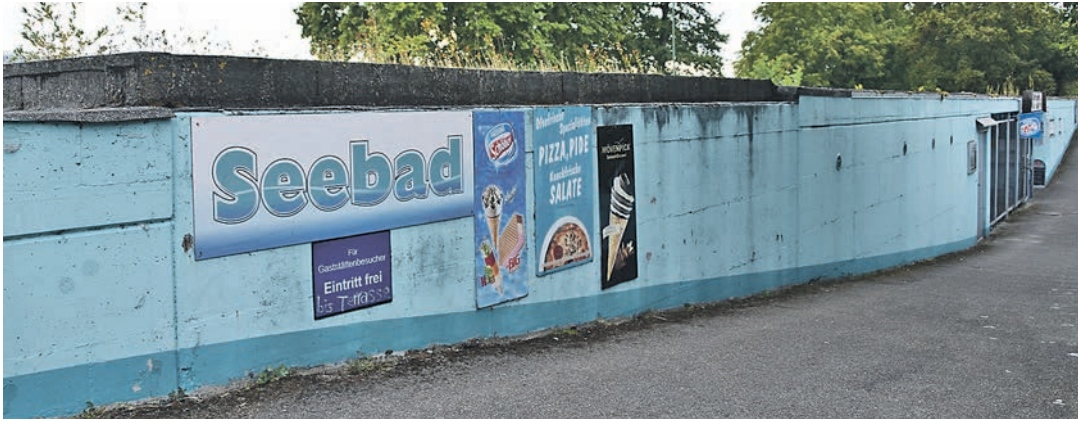
Das Seebad in Radolfzell soll in Rekordzeit saniert werden.
