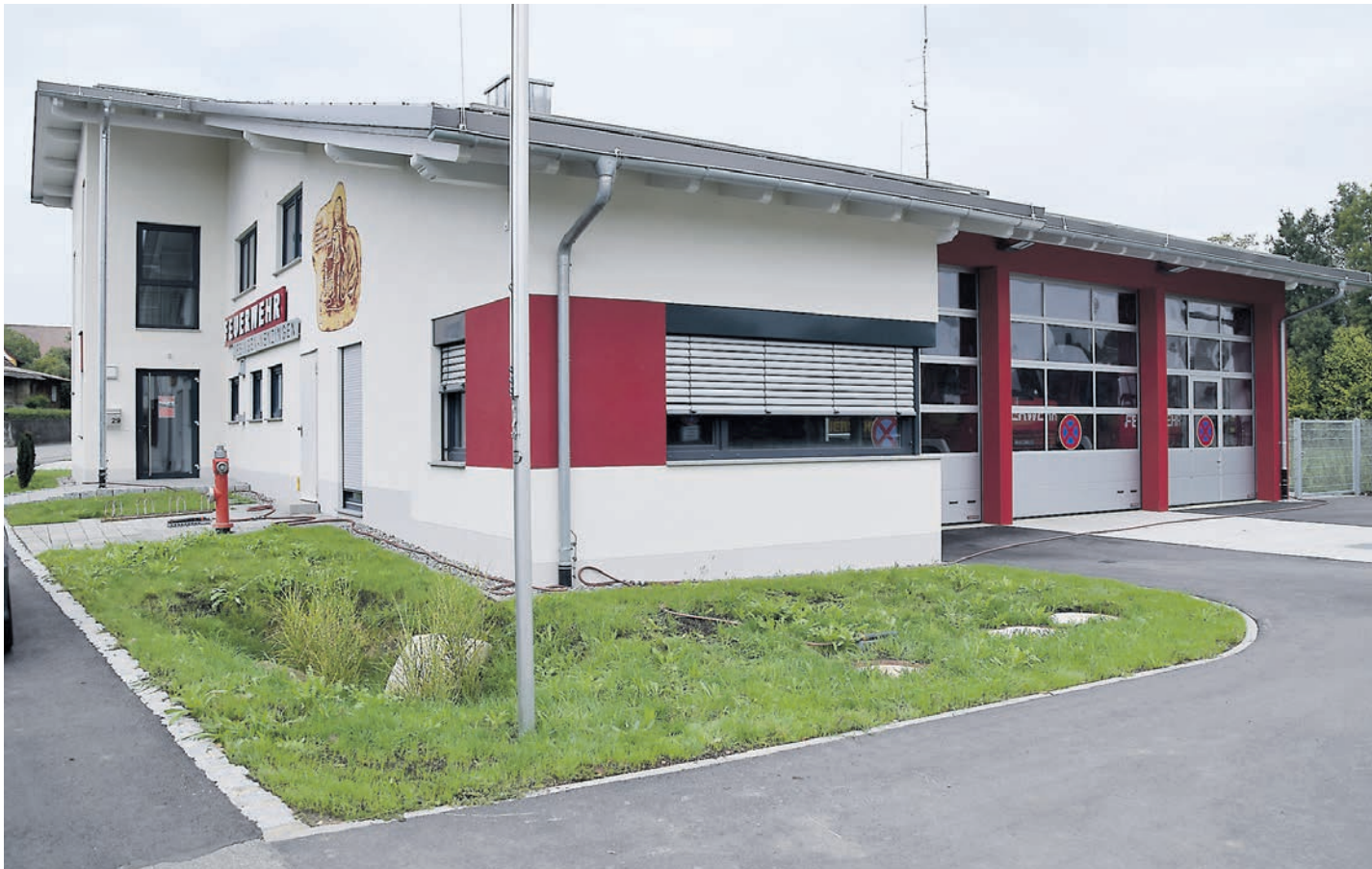
Umgebaut, angebaut, aufgestockt und saniert: das Feuerwehrhaus der Freiwilligen Feuerwehr Orsingen-Nenzingen in der Mühlenstraße 29 in Orsingen.
