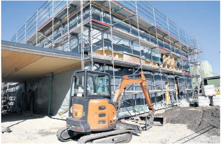
Während die Mensa fertig ist, biegt der angrenzende Neubau mit seiner Fertigstellung auf die Zielgerade ein.
