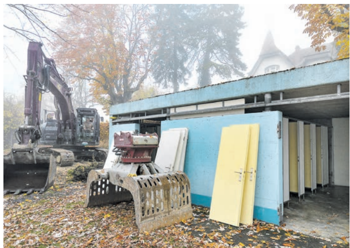
Oberbürgermeister Martin Staab legte beim Abriss des Seebades am vergangenen Montag gleich selbst mit Hand an und nahm im Führerhaus eines Baggers Platz.
