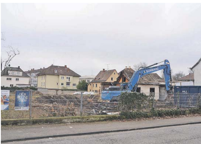
Die Abbrucharbeiten an der Friedenslinde haben begonnen. swb-Bild: stm
