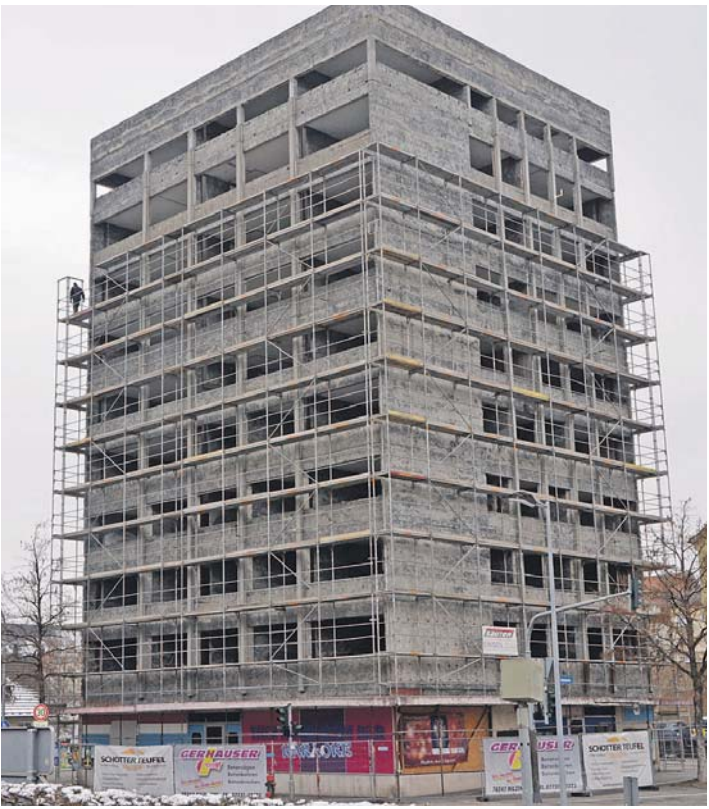
Das Conti Hochhaus ist fast schon wieder eingerüstet und soll durch die Firma Gerhäuser heruntergesägt werden. swb-Bild: stm
