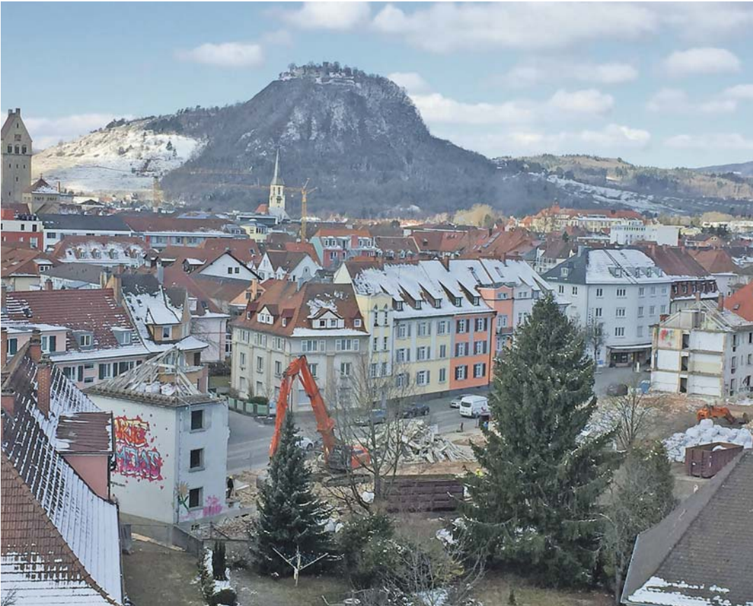
Der Abriss der Romeiasstraße ist abgeschlossen, wie das Foto des WOCHENBLATT-Leser Alexander Miller eindrucksvoll beweist. Auch die Aushubarbeiten am Herz-Jesu-Platz und Kunsthallenareal sind bereits weit fortgeschritten.
