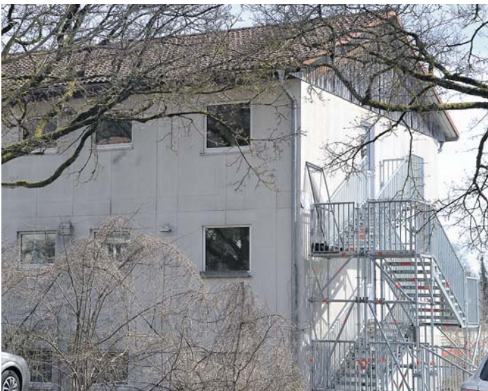
Die Unterkunft in der Friedinger Straße soll nach der Renovierung als Anschlussunterbringung zur Verfügung stehen. swb-Bild: stm
