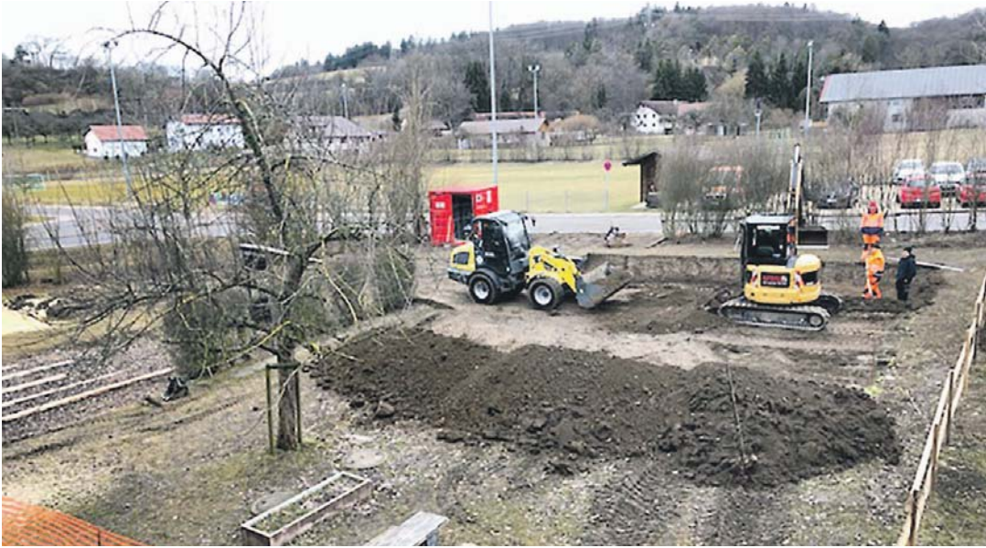
Azubis helfen Schülern – zwei angehende Baugeräteführer bei »Storz« erledigten die Erdarbeiten für den neuen Pausenbereich der Eigeltinger Gemeinschaftsschule: Haiko Binkert im Minibagger und Noah Zimmermann im Radlader.
