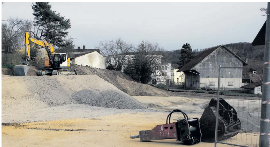
Der Bauplatz an der Zeppelinstraße muß am Hanggelände derzeit aufwändig gesichert werden.
