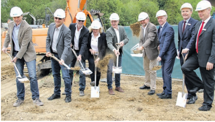
Spatenstich für den Neubau des Pflegeheims von links: Jens Stocker, ausführender Bauunternehmer; Architekt Michael Graf; Projektleiter Peer Mennecke; Claudia Zlatanovic; Pflegeheimbetreiber Maik Zlatanovic; Engens Stadtbaumeister Matthias Distler; Bürgermeister Johannes Moser; Jens Heinert, Vorstand Sparkasse Hegau-Bodensee, Finanzierungsträger; Michael Biehl, Kundenberater Sparkasse Hegau-Bodensee. swb-Bild: eck
