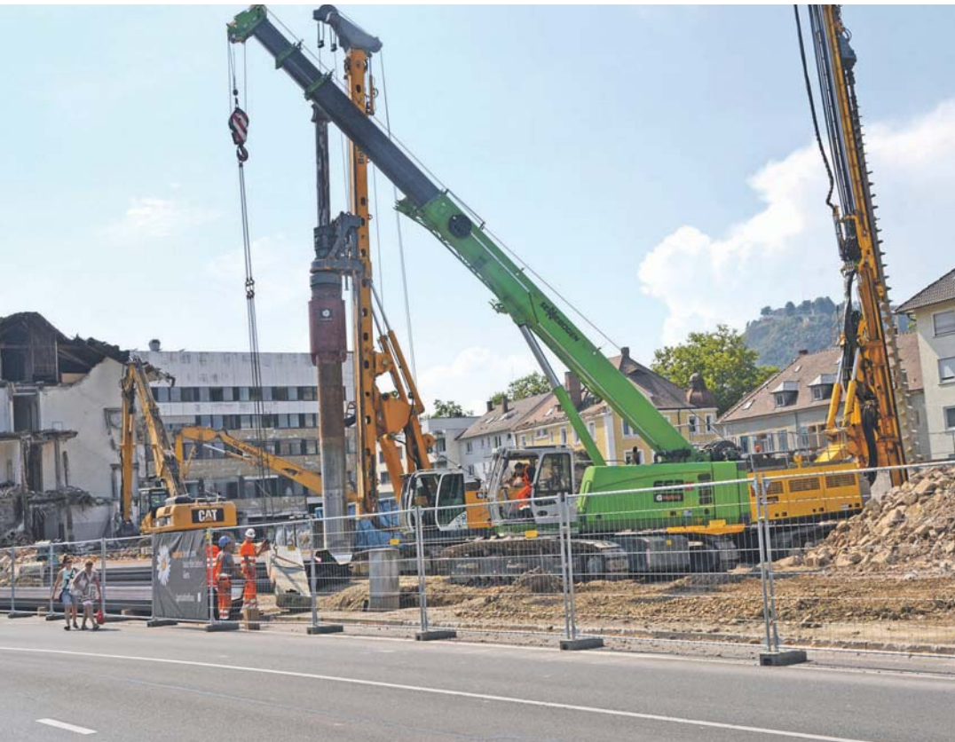
Die Abrissarbeiten für den Neubau des Einkaufs- und Dienstleistungszentrums sind in vollem Gange. Auf dem Zollareal haben die Bagger schon ganze Arbeit geleistet. Auch die Außenverschalung beim Holzerbau wurde schon abmontiert.
