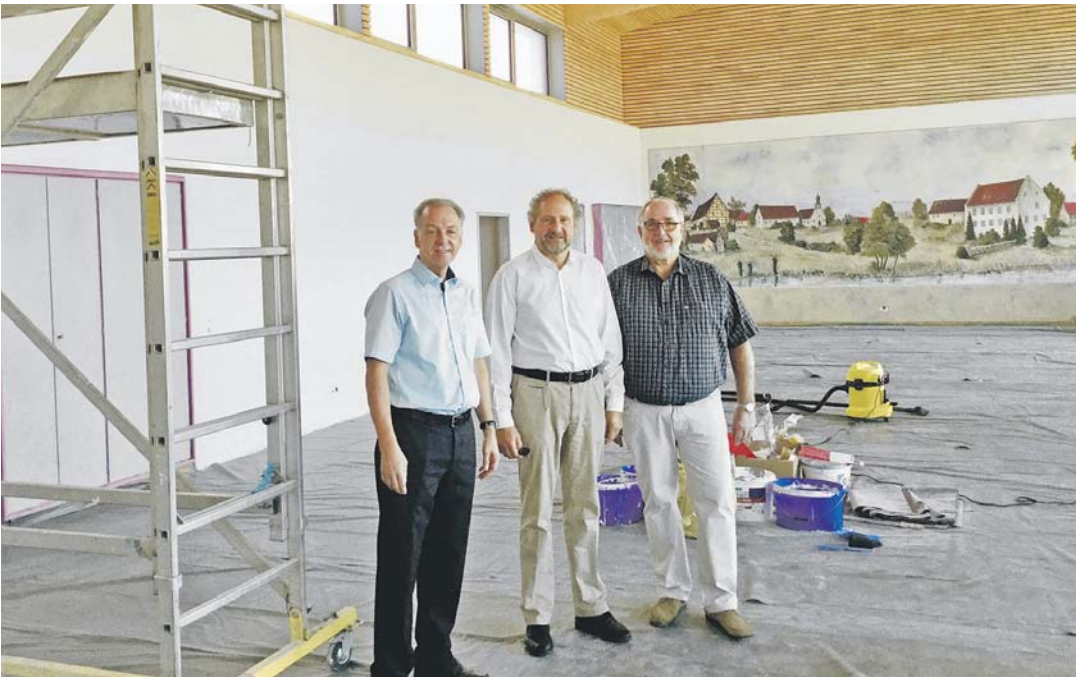
Bürgermeister Johannes Moser, Stadtbaumeister Matthias Distler und der Bittelbrunner Gemeinderat Klaus Hertenstein begutachteten den Baufortschritt in der Petersfelshalle in Bittelbrunn. swb-Bild: Stadt Engen
