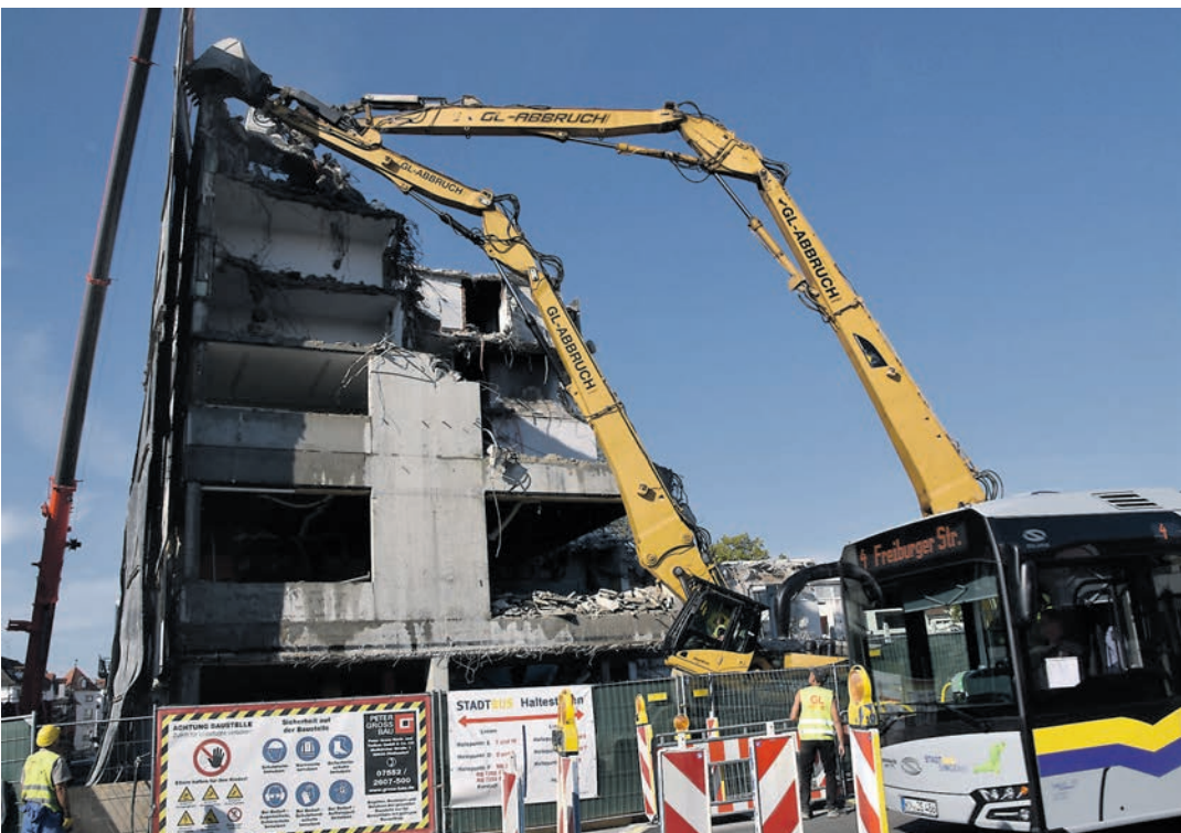
Aufgrund der Bauarbeiten am Bahnhofvorplatz kommt es zu Verzögerungen im Stadtbusverkehr. Bei der Fahrplanumstellung sollen Maßnahmen zur Linienoptimierung greifen. swb-Bild: stm
