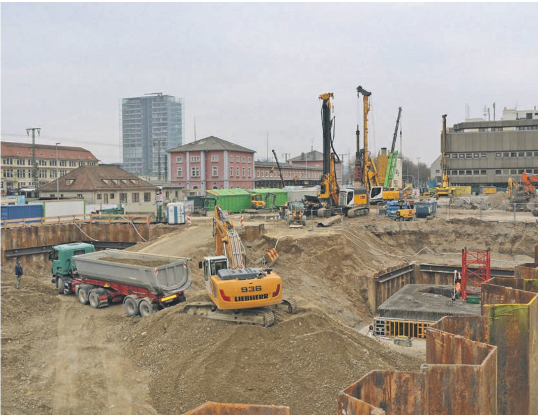
Nach dem Abriss der Gebäude zeigt sich Ende 2018 eine eindrucksvolle Baugrube, wo im Herbst 2020 das neue Einkaufszentrum in Singen stehen wird.
