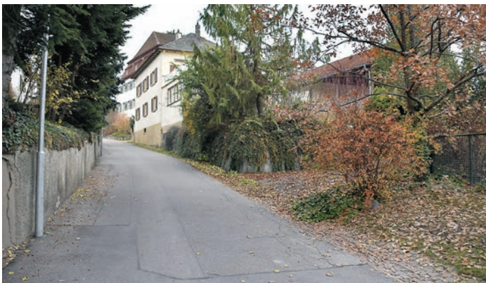
Auf dem Areal der ehemaligen Glaserei unterhalb des Bohlinger Schlosses sollen Neubauten entstehen. Das Bestandsgebäude direkt an der Straße bleibt bestehen.
