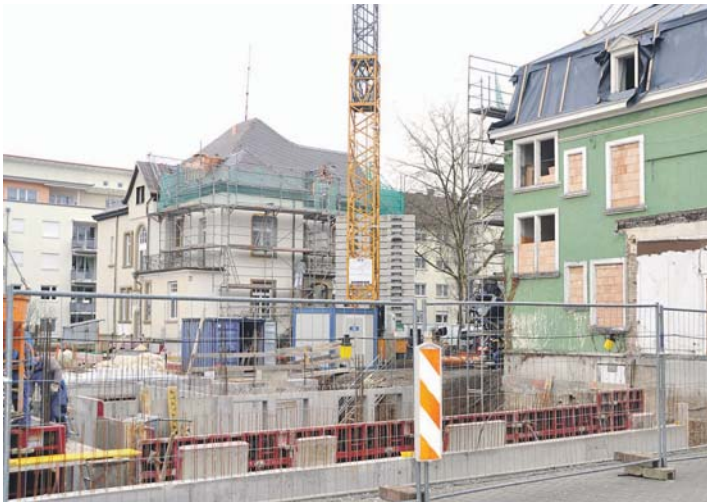
Der Hospizverein Singen-Hegau hat die Villa Wetzstein (Bildhintergrund) bezogen, während die Bauarbeiten zum Hospiz- und Palliativzentrum weitergehen. Die Fertigstellung der Tiefgarage ist schon weit vorangeschritten.
