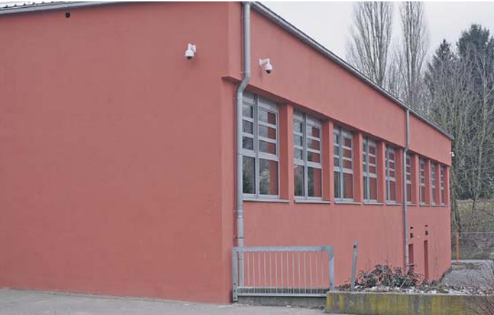
Aus Gründen der Energieersparnis wie Diskretion gibt es die große Fensterfront an der »neuen« Ten-Brink-Turnhalle nicht mehr.
