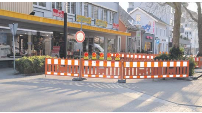
Aufgrund der anstehenden Bauarbeiten im zweiten Teilstück der Hegastraße ist eine Einfahrt für Kunden in diesen Bereich jetzt nicht mehr möglich.
