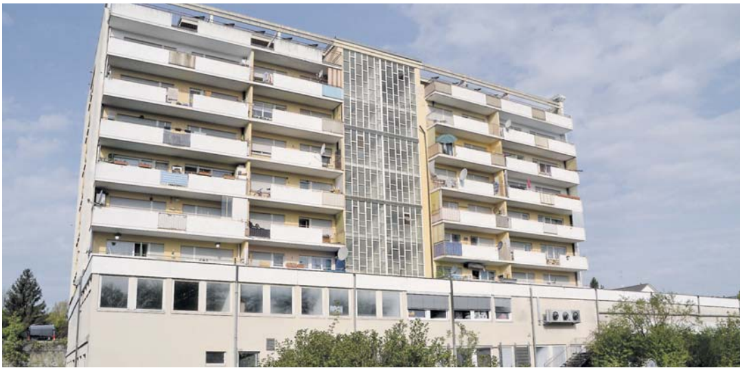
Für das Areal am ehemaligen »Hotel Landerer« gibt es eine Konzeption für eine künftige Bebauung. swb-Bild: stm
