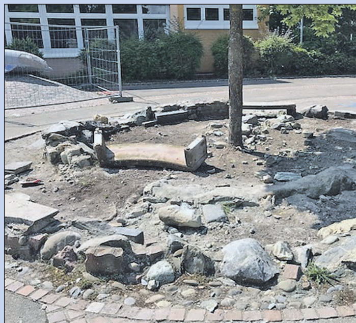
Sinnlose Zerstörungen an der Bruderhofschule. Die Polizei ist eingeschaltet und ermittelt in allen Richtungen.
