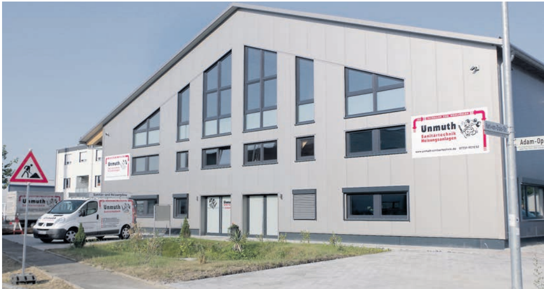
Seit April 2017 ist Unmuth Sanitärtechnik im neuen Gewerbegebiet Nord Rielasingen beheimatet. Der großzügige Neubau bietet die Reserven für die weitere Entwicklung des Handwerksunternehmens. swb-Bild: of
