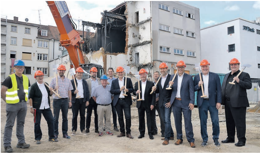
Fast zehn Jahre harpte die Kunsthalle auf die Realisierung eines Bauprojekts. Die Baugenossenschaft Oberzellerhau und die Oswa wollen nach dem Abriss der Kunsthalle hier über 100 Wohnungen bauen. swb-Bild: stm
