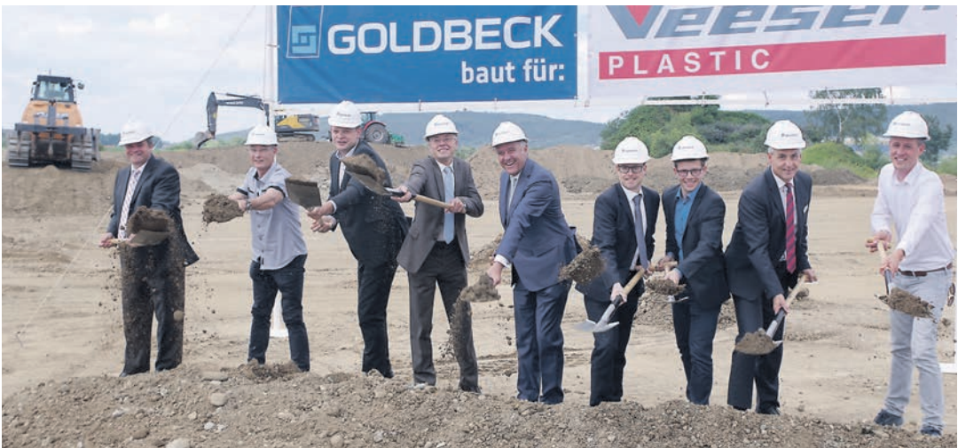
Mit dem offiziellen Spatenstich wurde nun der Start für den Neubau des Unternehmens Veesser in Steißlingen vollzogen. Das familiengeführte Spitzguss-Unternehmen zieht im kommenden Frühjahr von Konstanz in den Hegau um.
