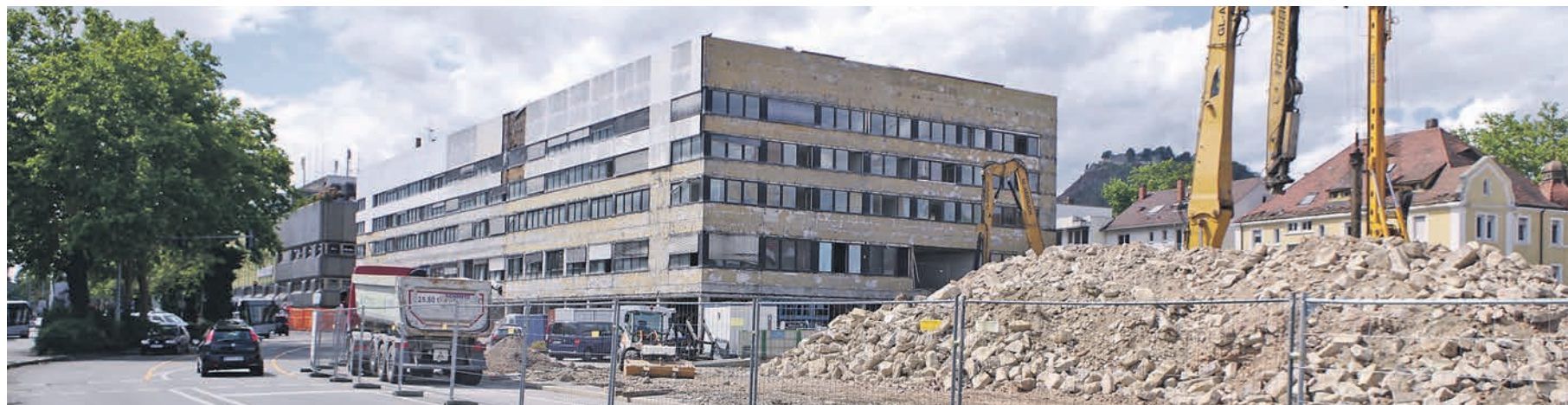
Während die Abrissarbeiten am Holzerbau und am ehemaligen Zollamt beeindruckend voranschreiten, hat der Umbau am Bahnhofplatz spürbar begonnen. swb-Bild: of
