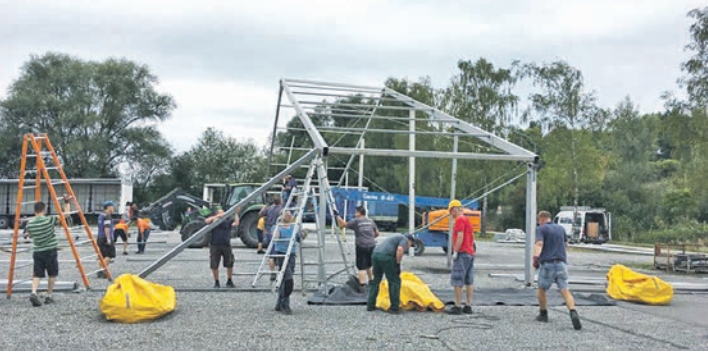
Stück für Stück wurde am Samstag das Gerippe des Sichelhenkezelts aufgestellt, bevor die Zeltplanen eingezogen werden konnten. swb-Bild: dh
