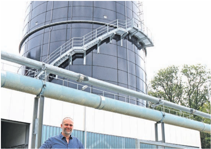
Der hohe Gasspeicher-Turm ergänzt die Silhouette der Kläranlage Bibertal in Ramsen. Betriebsleiter Björn Uelzen, freut's: »Die Sanierung der Anlage hat dank der guten Arbeit aller Beteiligten reibungslos funktioniert.«
