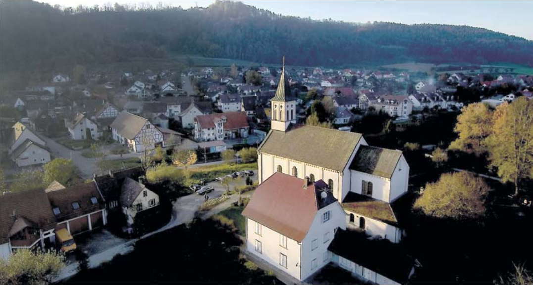
Sie will der Bauförderkreis aus Stahringen erhalten: die St. Zeno Kirche.
