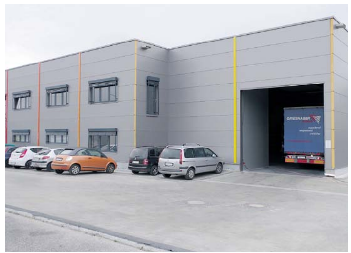
Für einen sehr schnellen und auch umfassenden Umschlag von mehreren hundert Tonnen Eisenteilen pro Tag ist die nun fertiggestellte neue Lagerhalle des Unternehmens I. Con Garcia geprägt. Durch den verfügbaren Platz werden nun Betriebsabläufe wesentlich optimiert. swb-Bilder: of
