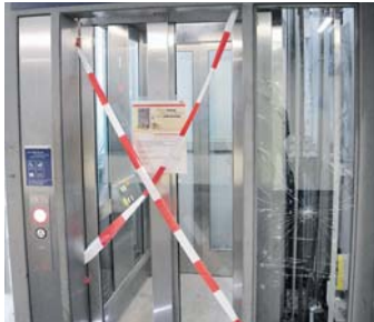
Die demolierten Aufzüge am Bahnhof.
