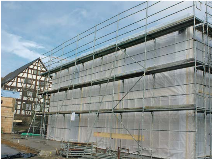
Der katholische Kindergarten in Steißlingen ist nach dem Richtfest schon sehr gut erkennbar.
