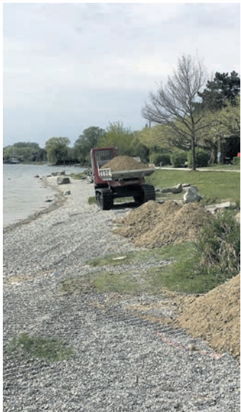
Das letzte Hochwasser im Jahr 2016 hat Schäden am Bodenseeufer hinterlassen. Diese wurden nun beseitigt. swb-Bild: Stadt
