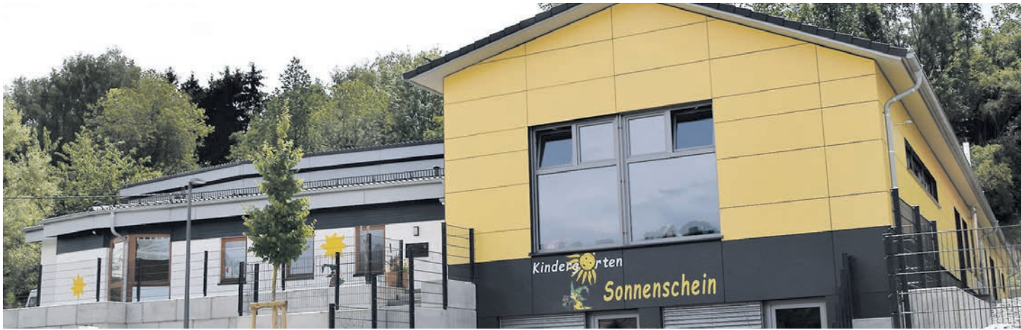
Der Altbau wurde abgerissen, ein Neubau ist entstanden, und der Erweiterungsbau wurde saniert: Das Ende dieser Baumaßnahmen feiert der Kindergarten »Sonnenschein« in Stockach-Zizenhausen am Samstag, 21. Juli, ab 14 Uhr mit einem Tag der offenen Tür. swb-Bild: sw
