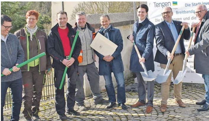
Spatenstich in Blumenfeld - Im Bild von links : Christian Weber (Bauamt Tengen), Gemeinderätin Renate Hönscher, Marco Fluck (Ortschaftsrat Blumenfeld), Ludwig Küderle (Bauhofleiter Tengen), der Hauptamtsleiter der Gemeinde Hilzingen Markus Wannemacher, Bürgermeister Marian Schreier (Stadt Tengen), Bürgermeister Rupert Metzler (Gemeinde Hilzingen) und der Geschäftsführer der Breitbandberatung Baden Württemberg Thilo Kübler. swb-Bild: hz
