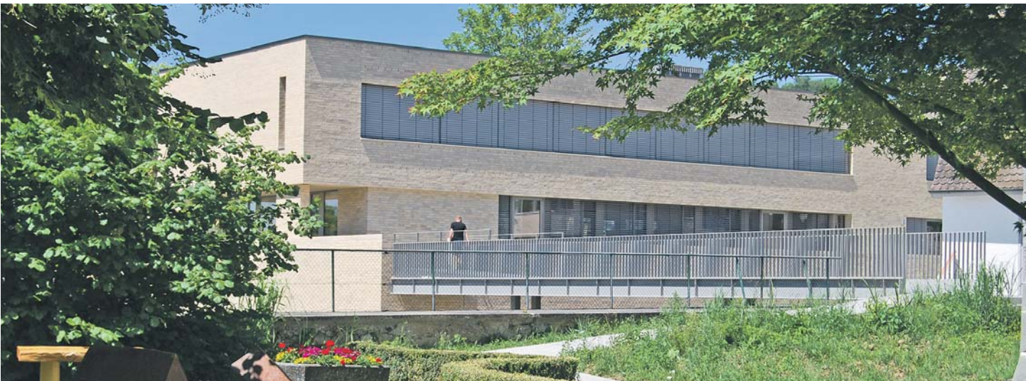
Mit einem rauschenden Einweihungswochenende wurde das neue Campus- und Musikgebäude sowie das renovierte Schloss an der Evangelischen Schule Schloss Gaienhofen offiziell in Betrieb 2016 genommen. swb-Bild: Schule
