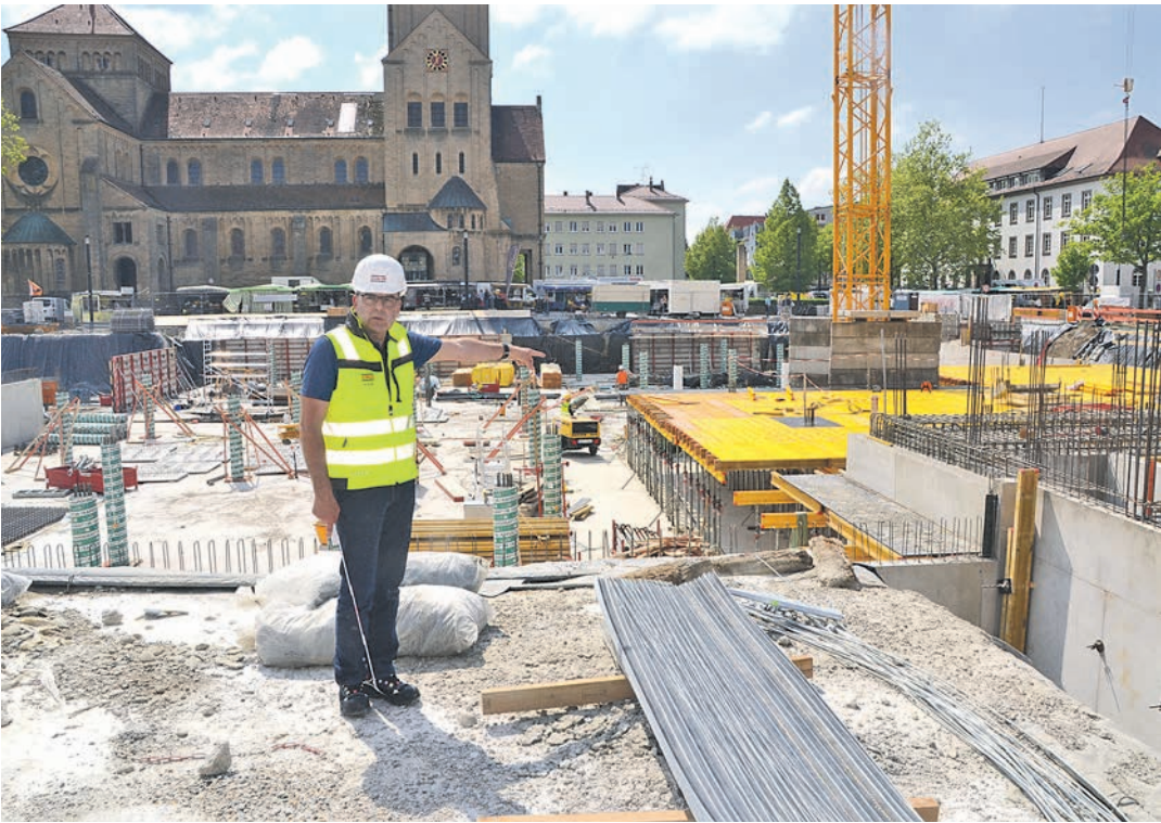
Der Oberbauleiter von Züblin, Hans-Georg Groß, zeigt den Baufortschritt auf dem Herz-Jesu-Platz. Vorne rechts ist das Punktgebäude (später viergeschossig) zu erkennen, in dem im Erdgeschoss ein Café zur Platzseite entstehen wird. Auf der linken Seite (Mitte) ist die äußere Wand der öffentlichen Tiefgarage zu erkennen.
