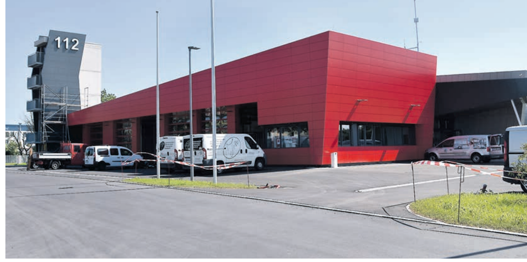
Das neue Feuerwehrhaus, dessen Einweihung noch bevorsteht kann am Sonntag, 8. Juli, schon vorab besichtigt werden.
