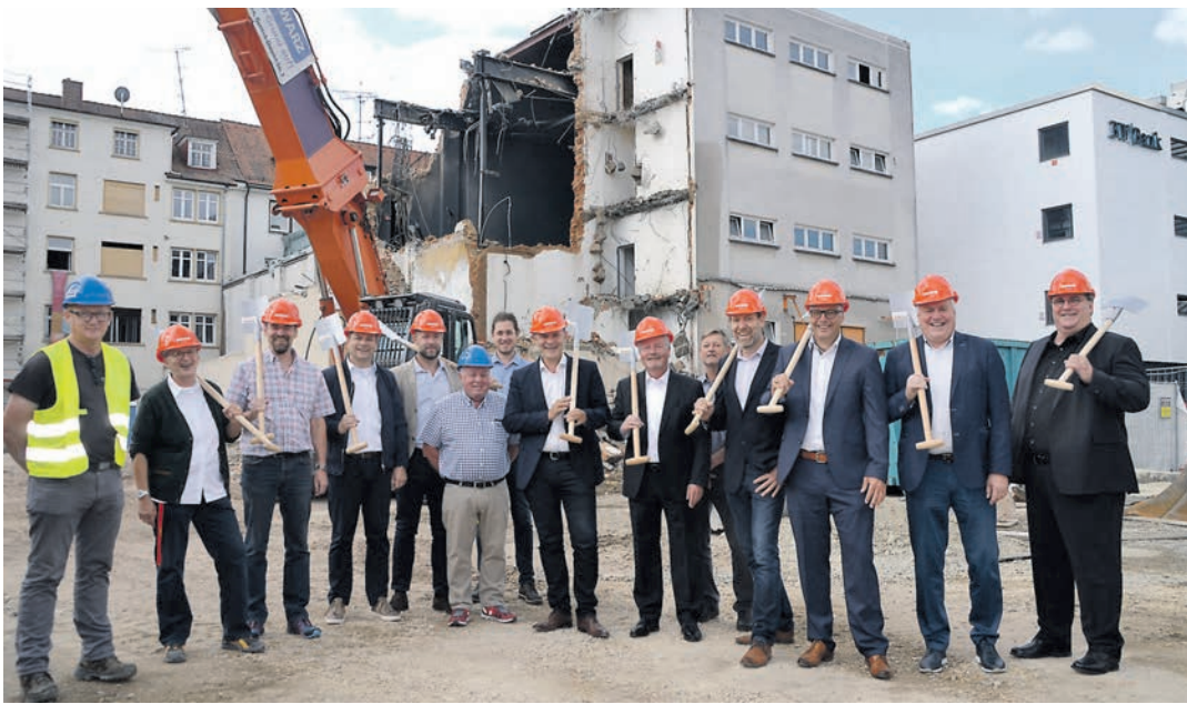
Fast zehn Jahre hararte die Kunsthalle auf die Realisierung eines Bauprojekts. Die Baugenossenschaft Oberzellerhau und die Oswa wollen nach dem Abriss der Kunsthalle hier über 100 Wohnungen bauen. swb-Bild: stm
