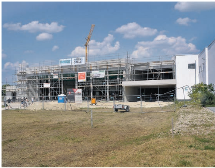
Die Mehrzweckhalle in Beuren nimmt allmählich Formen an. Im Frühjahr 2019 ist Eröffnung geplant.
