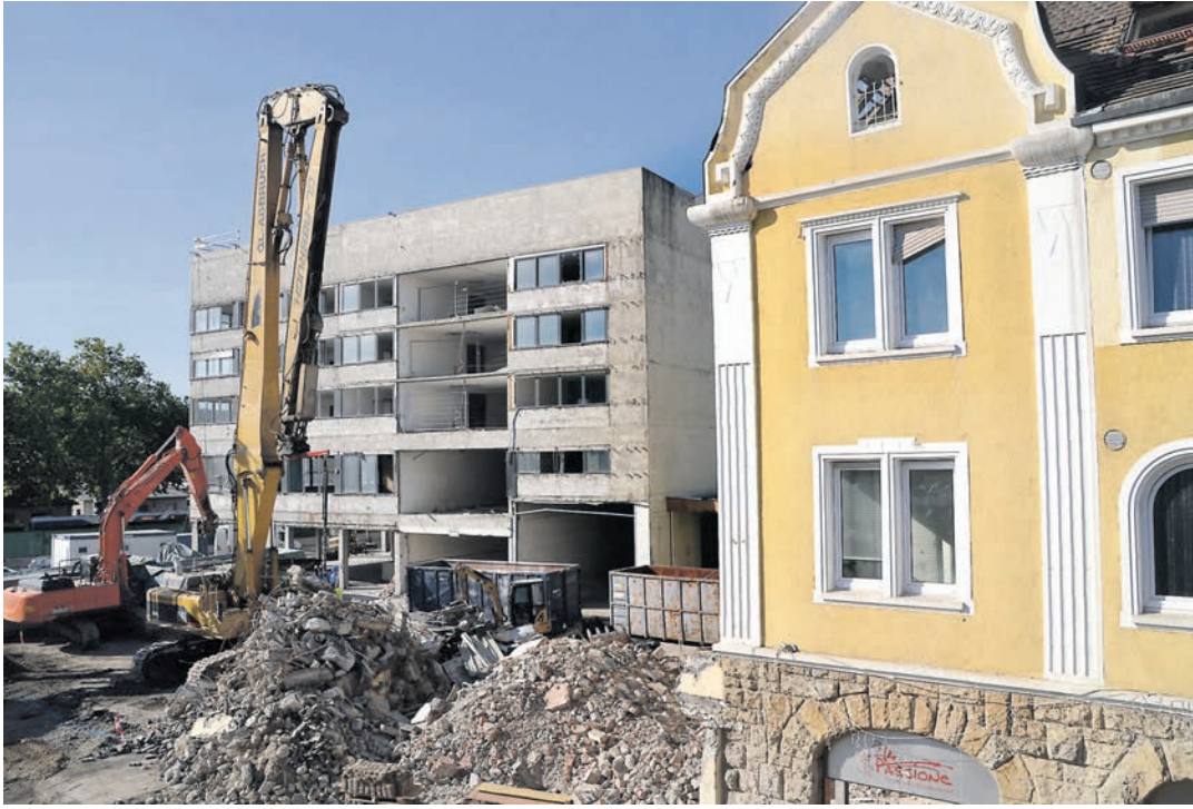
Der Abbruch des Holzerbaus (links) und vor allem der Rückbau des denkmalgeschützten Hotel Viktoria (rechts) sind eine Herausforderung.
