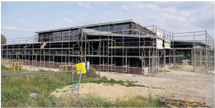
Der Bau der Volkertshauser Wiesengrundhalle schreitet munter voran. In der jüngsten Sitzung des Gemeinderats konnte bereits der Bau des Außenbereichs vergeben werden. swb-Bild: of
