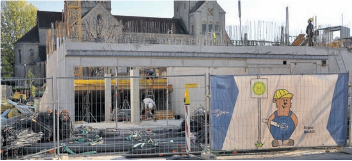
Der Bau der Tiefgarage am Herz-Jesu-Platz soll bis Ende des Jahres abgeschlossen sein. swb-Bild: stm
