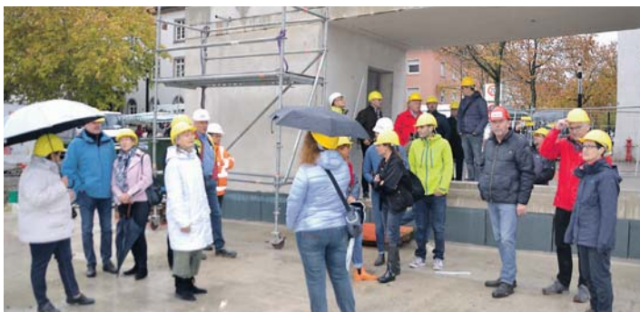
Über den Baufortschritt am Singener Herz-Jesu-Platz wurde am Samstag informiert.
