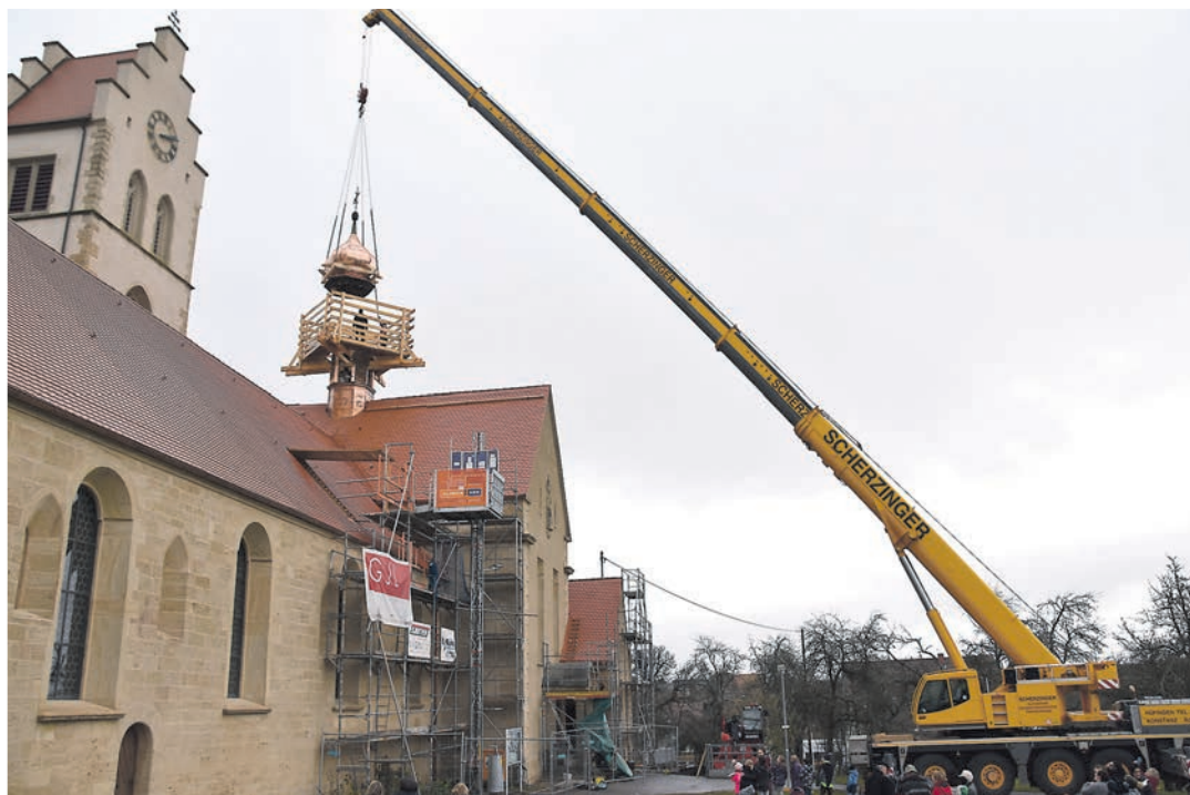
Mit einem Autokran wurde die frisch renovierte Turmspitze wieder an ihren alten Platz zurück gesetzt.
